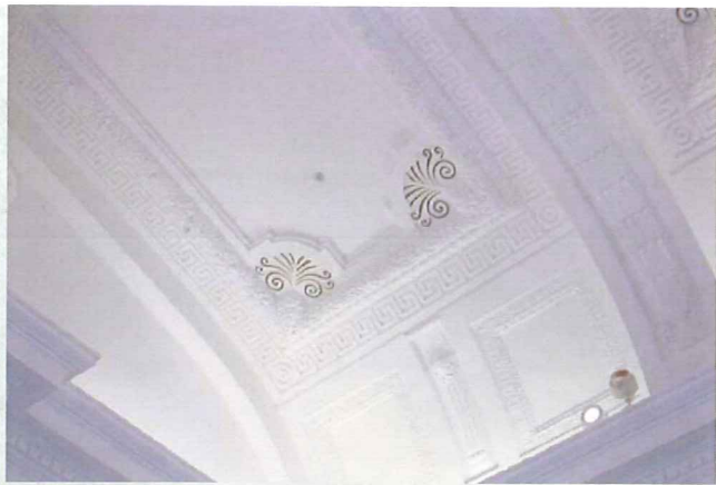
修復現場の一例
