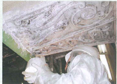
現場での作業風景
